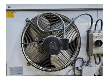
VIII3 Mot AFT71/4A-7 /U11 AN-ART.NR. 300870 WSK 132 °C 1. F **IP55** EN 60034 1,15/2.00 A 2-420/220-240 V 1410/min 50 Hz 0,25 kW cos# 0,74 0,79/1,37 A 1710/min 60Hz 380-440/220-254 V YΔ cos# 0,74 0,25 kW
